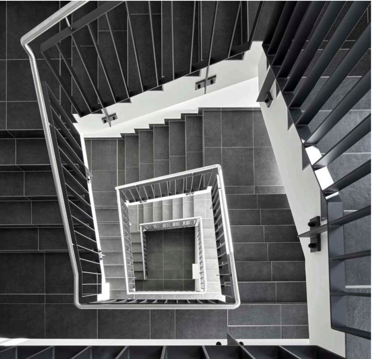
BZL Seminarhotel · Seminar hotel Berghaus, Lauterbach, Deutschland · Germany / Architekt · Architect: herbert architekten GbR / Photo: Jochen Stüber
