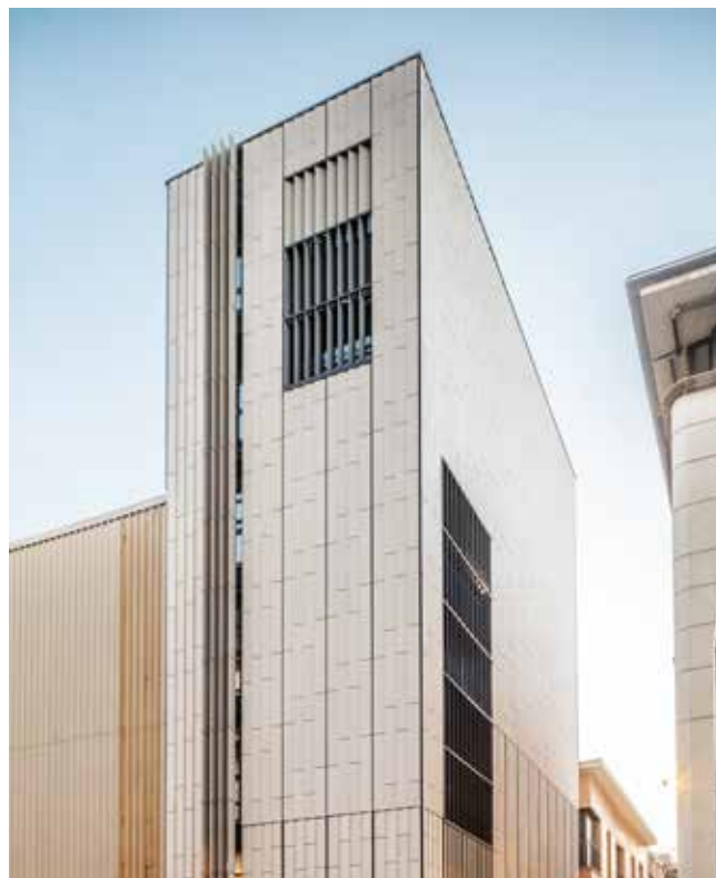
Can Serras Edificio de Oficinas, Granollers, España Arquitecto: Aquidos Arquitectes / Año: 2019 / Foto: Adrià Goula
