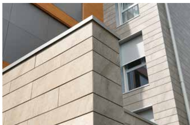
Edificio residencial Via Mocengio, Milán, Italia / Arquitecto: Beretta Associati / Año: 2019 / Foto: Lorenzo Rimondi
