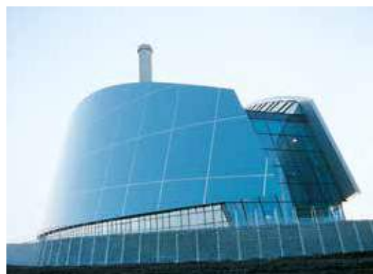
Central de cogeneración, Viborg, Dinamarca Arquitecto: Arkitekterne, Peter Kjølgaard & Thomas Pedersen M.A.A., Viborg
